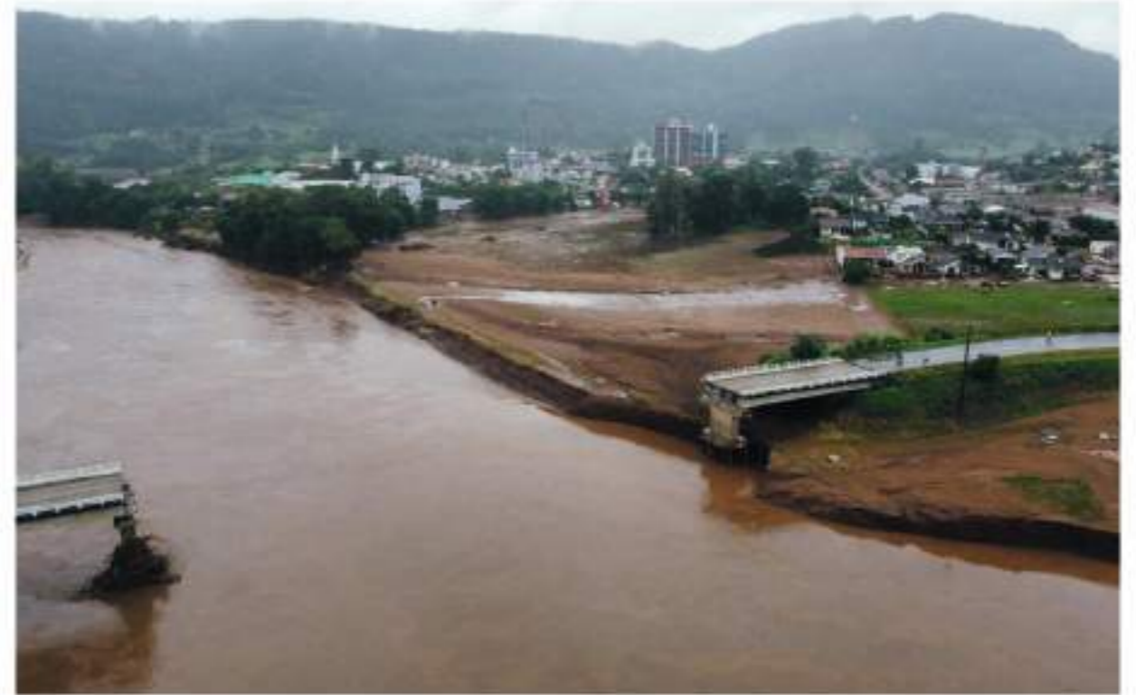
Os municípios de Travesseiro e Marques de Souza ficaram sem ligação devido à destruição da ponte
