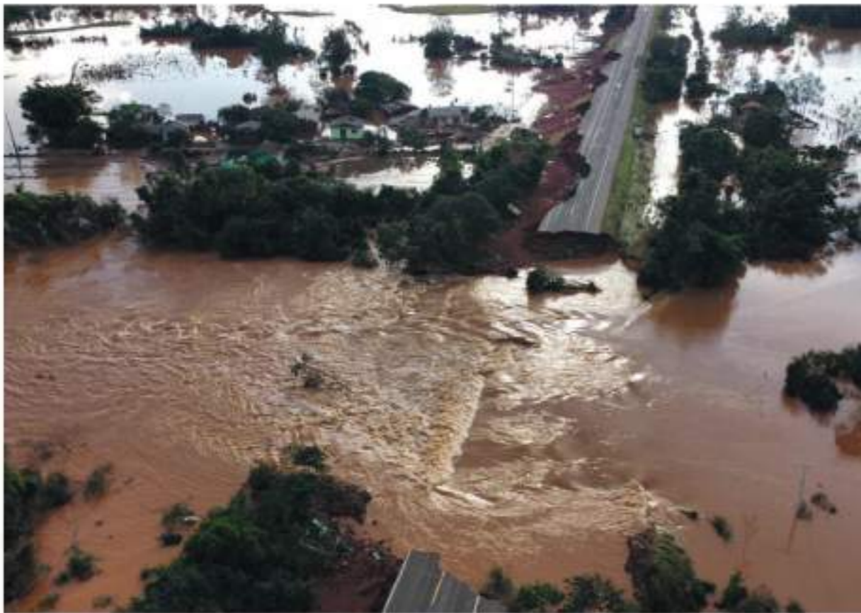
A rodovia ERS-287, em Venâncio Aires, também foi destruída
