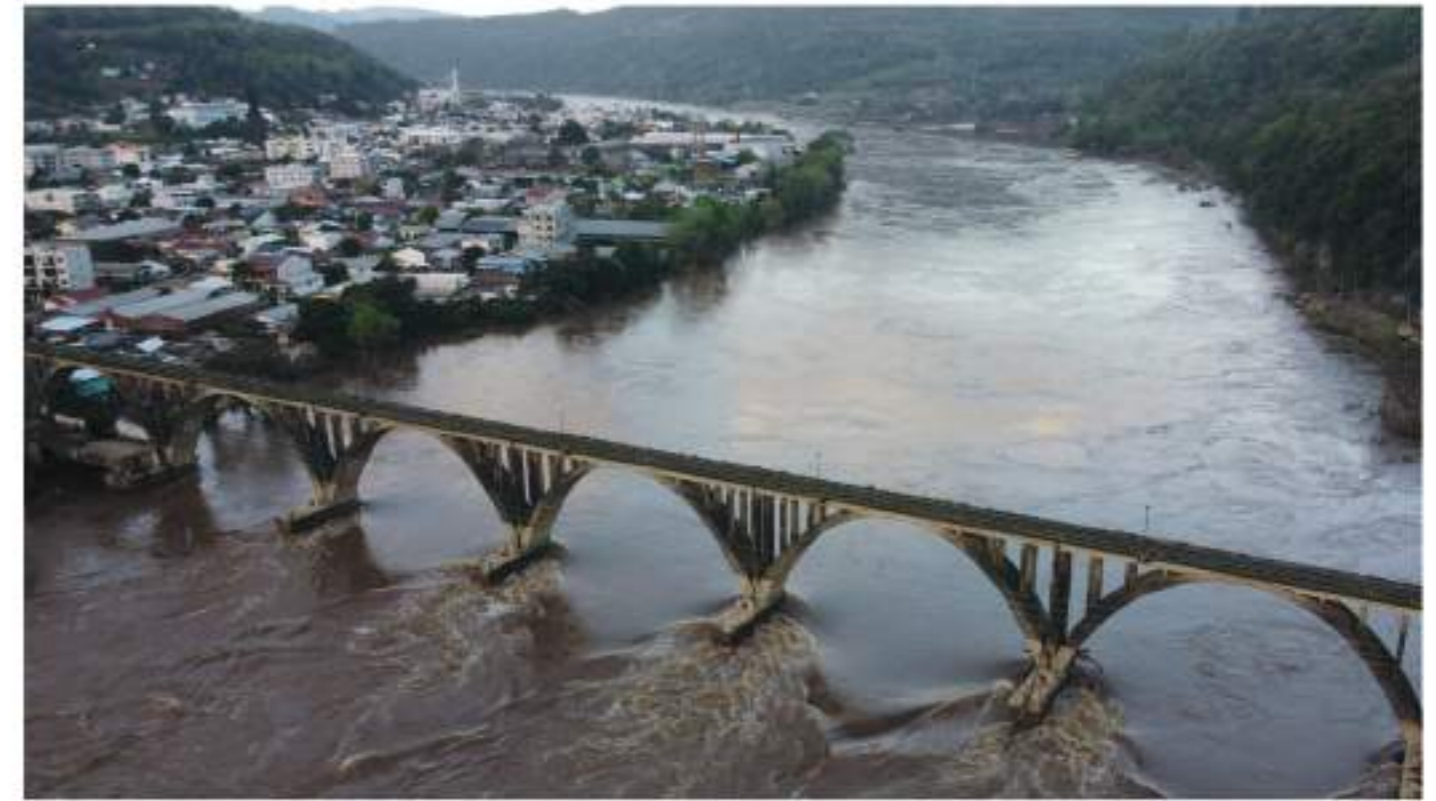
Entre Muçum e Roca Sales, ponte rodoferroviária Brochado da Rocha também foi destruída. Registro mostra instantes antes de ser levada pela água.
